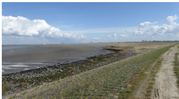
De 5 km brede Westerschelde ter hoogte van Baalhoek Cutterzuiger Scheldt-River werkzaam in de Westerschelde.
